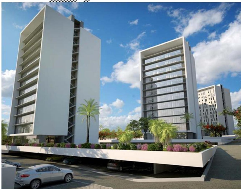
As Zenith Towers, projeto da Gestimóvel, estão a ser construídas pela Casais em Talatona
